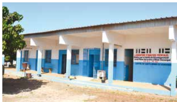
Quelques unes des premières réalisations...
